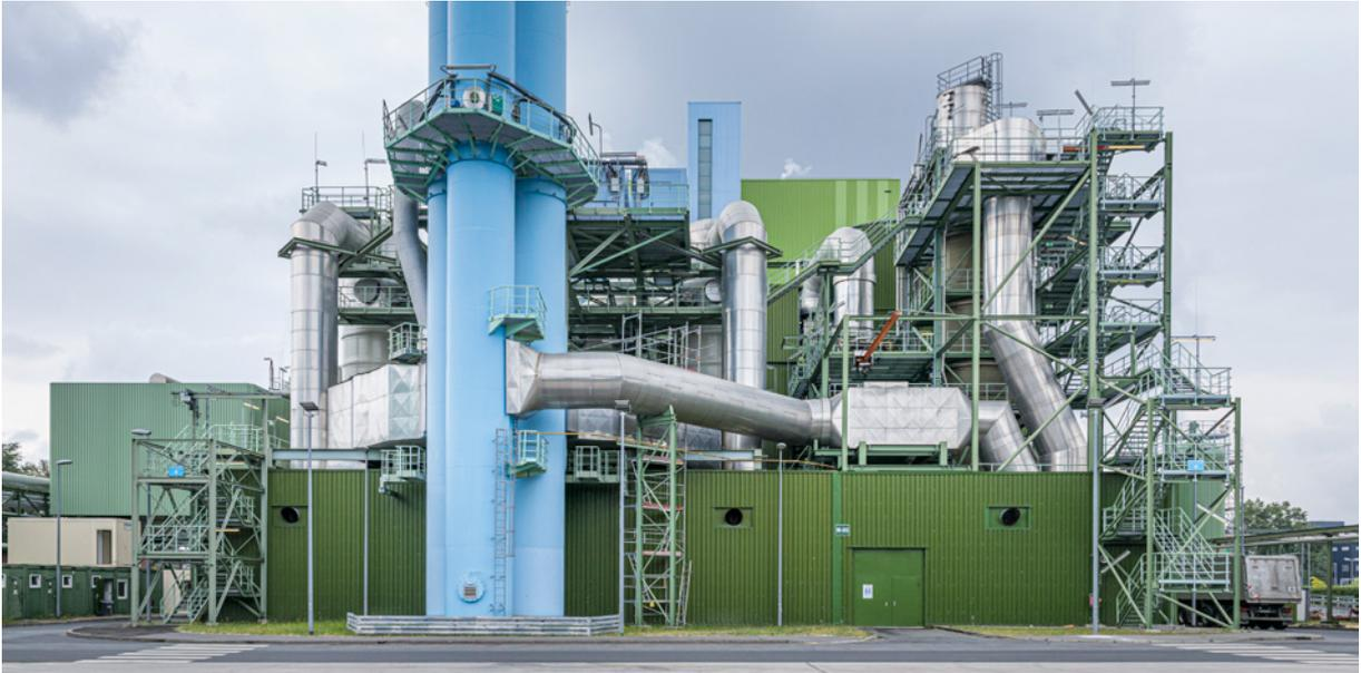
Innere Werte: Herzstücke des neuen Blockheizkraftwerks sind zehn Gasmotoren mit insgesamt 100 Megawatt elektrischer und 100 Megawatt thermischer Leistung.
