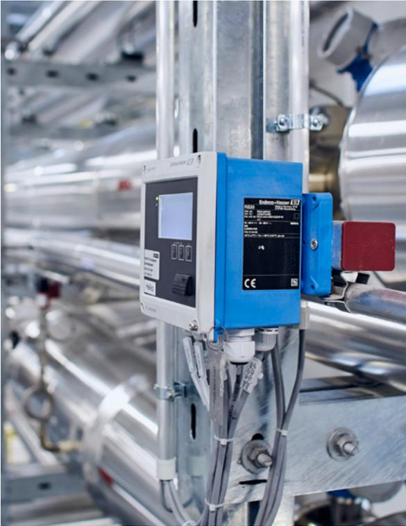
Der Dampfrechner EngyCal RS33 erfasst Dampfmasse und Energiefluss.
