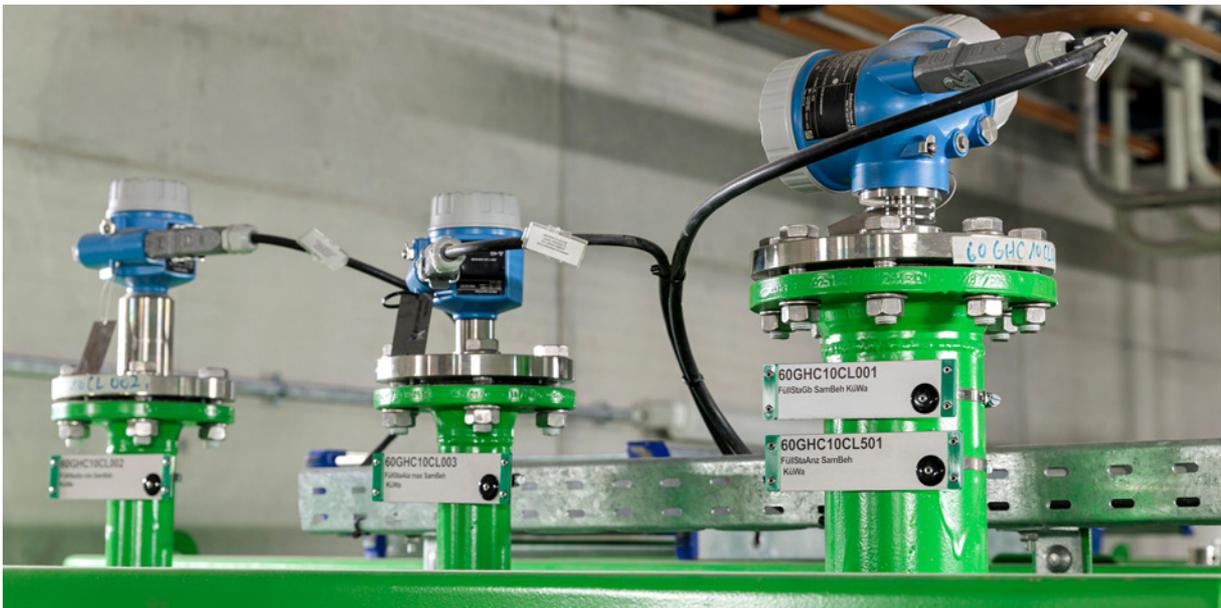
Große Bandbreite: Beim Kühlwassersammelbehälter wurde eine kontinuierliche Micropilot-Füllstandsmessung mit einem Liquiphant-Grenzstandschalter und einem kapazitiven Liquicap-Sensor kombiniert.
