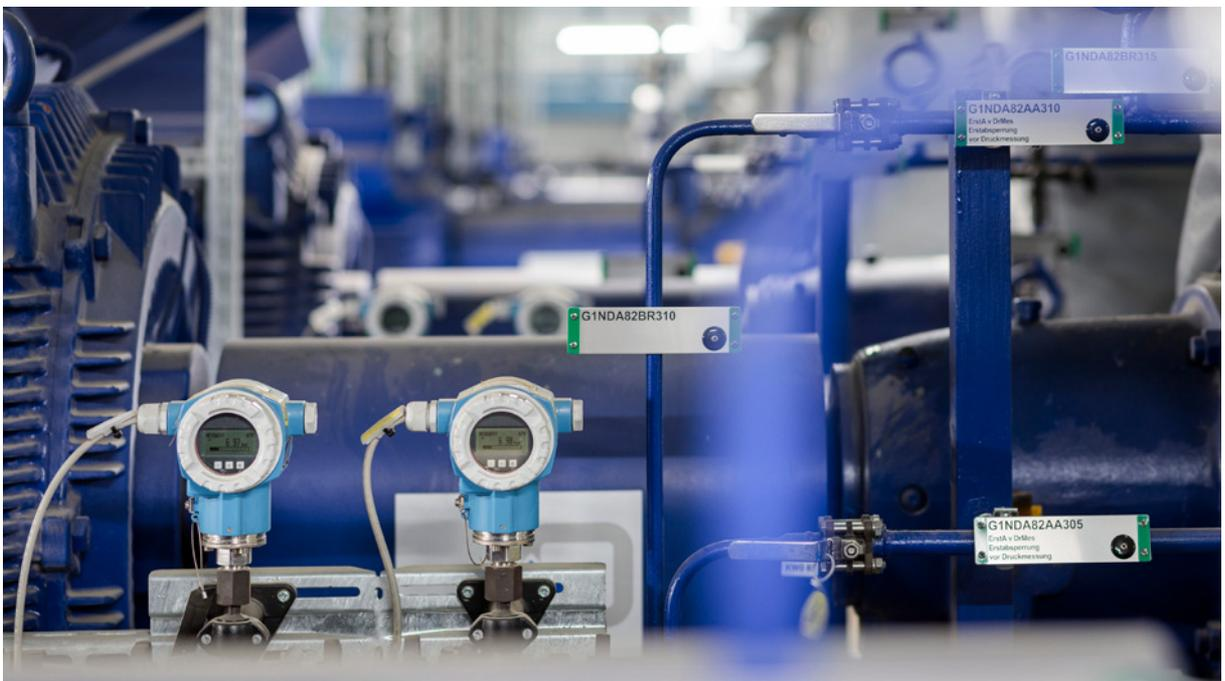
Prozessdrucküberwachung: Cerabar S-Drucktransmitter messen den Prozessdruck zur Überwachung der Pumpen.
