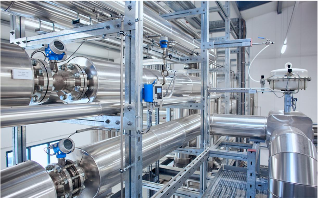
Vortex-Durchflussmessgeräte und Dampfrechner: Zur Dampfmessung kommen andere Messinstrumente als in der Milchverarbeitung zum Einsatz.
