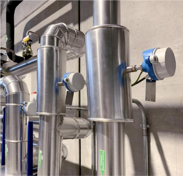
Hohe Genauigkeit: Widerstandsthermometer erfassen die Temperatur des Kühlwassers.
