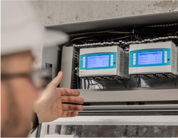
Perfekter Überblick: Projektgenieur Kevin Kummer zeigt, wie Endress+Hauser RMS621-Wärmemengenrechner den Energiefluss in verschiedenen Wärmekreisläufen messen.
