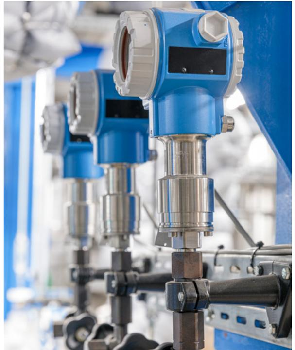
Auf Nummer sicher: Cerabar S-Drucktransmitter überwachen die richtige Funktion der Pumpen.
