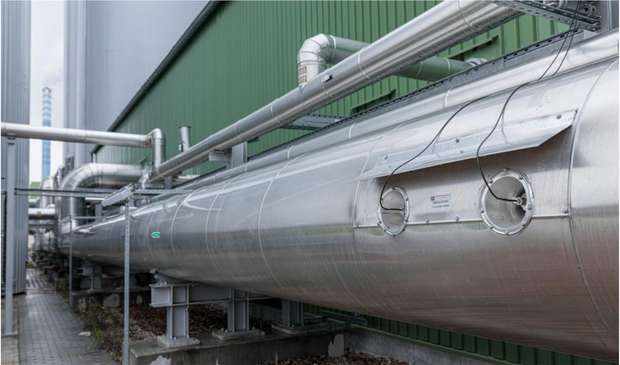
Leichte Installation: Clamp-On Ultraschallsensoren werden überall in der Anlage eingesetzt.
