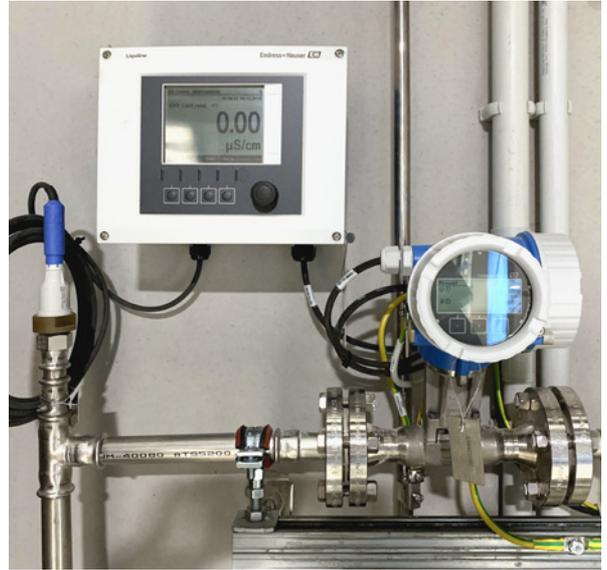
Multitalent: Der Proline Prowirl ist ein Wirbelzähler für Dampf, Gas und Flüssigkeiten (rechts). Bei der Leitfähigkeits-Überwachung kommt ein Liquiline-Messumformer zum Einsatz (links).
