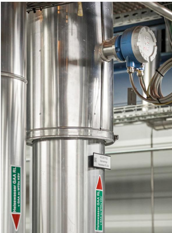
Wärmemengenmessung von Heisswasser: Magnetisch induktives Durchflussmessgerät Promag P mit abgesetzter Elektronik.
