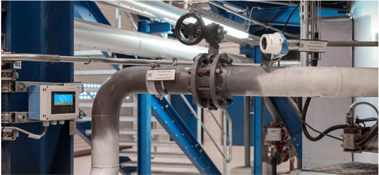
Für hohe Prozesstemperaturen: Thermoelement Omnigrad TAF am Wirbelschichtofen in Kombination mit Feldanzeiger RIA46.
