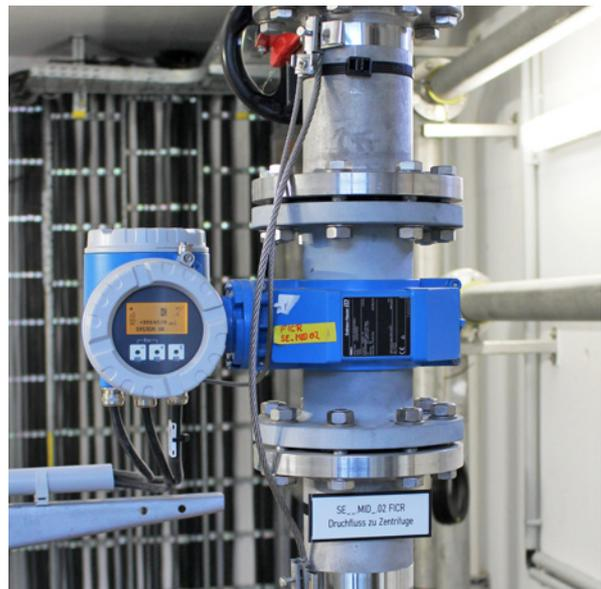
Magnetisch-induktive Durchflussmessung im ausgefäulten Klärschlamm (Zulauf Zentrifuge).
