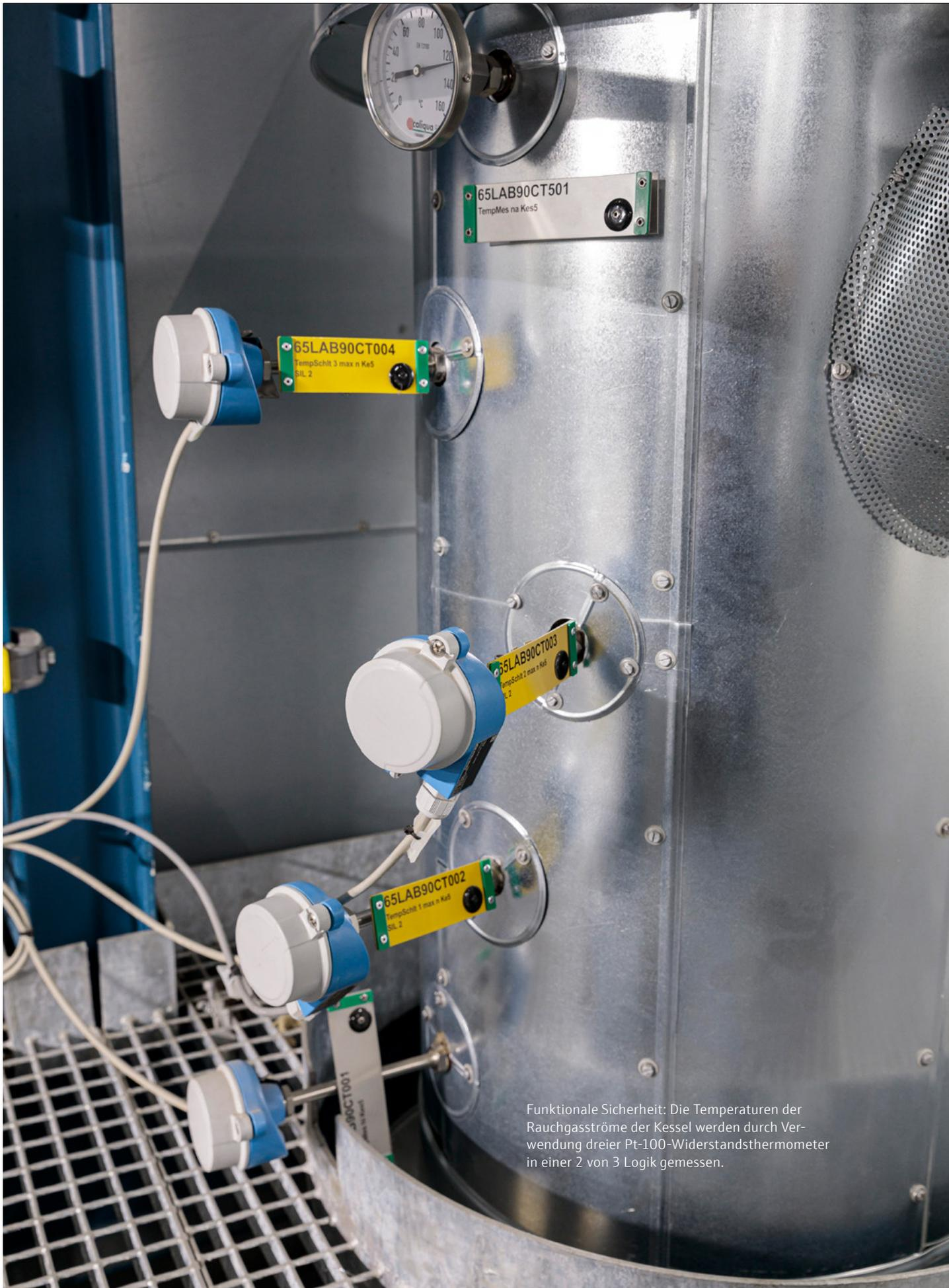
Funktionale Sicherheit: Die Temperaturen der Rauchgasströme der Kessel werden durch Verwendung dreier Pt-100-Widerstandsthermometer in einer 2 von 3 Logik gemessen.
