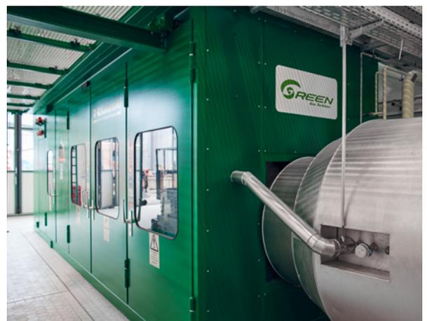
Mit der Gasturbine wird Elektrizität, Dampf und Warmwasser erzeugt.
