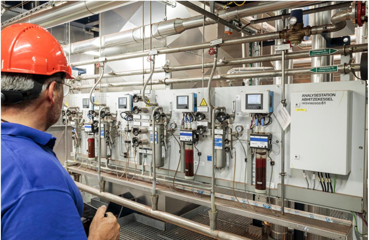
Alles im Blick: Am Abhitzekeessel befindet sich ein Analysepanel mit Liquiline Transmitter und Memosens pH- und Leitfähigkeitssensoren.
